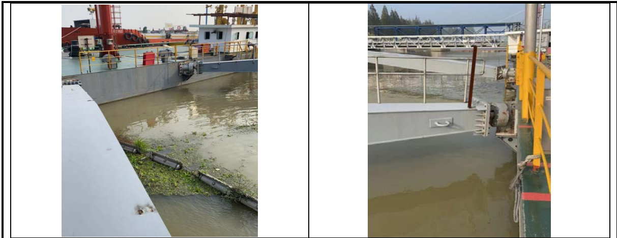
11#码头结构隐患治理后照片
