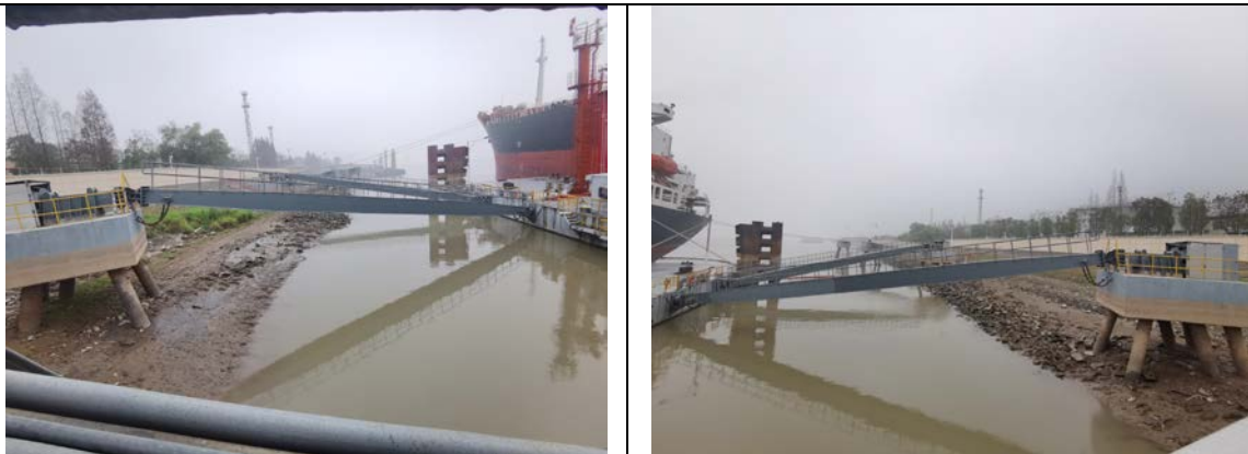
12#码头结构隐患治理后照片
