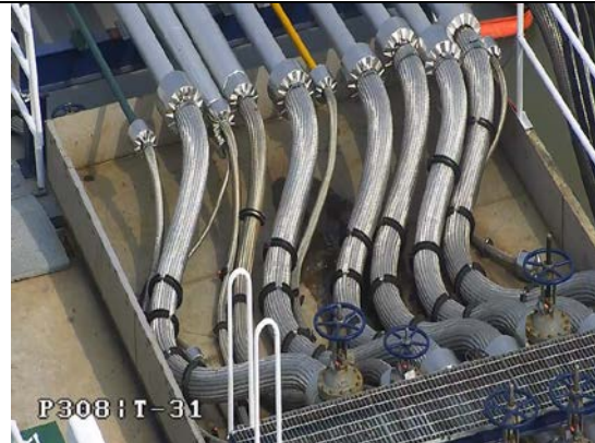
2#码头新增集油汇管及集油舱照片
