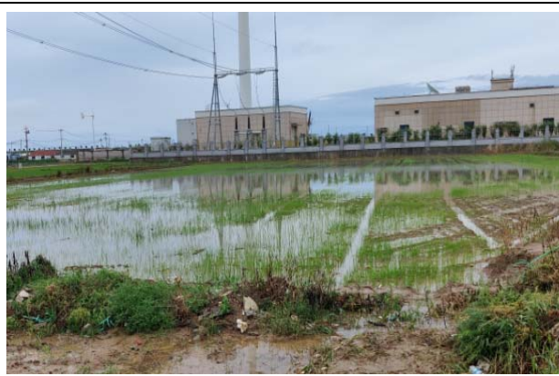
图 6.1-6 施工临时占地植被恢复
