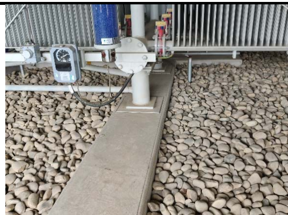
图 6.1-13 主要电气设备安装减震垫
