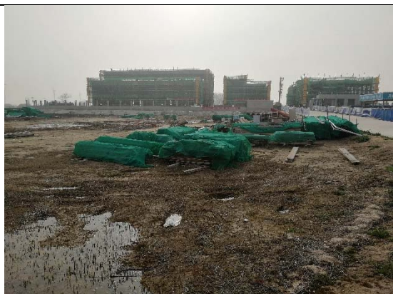
图 6.1-3 建筑材料采取苫盖措施
