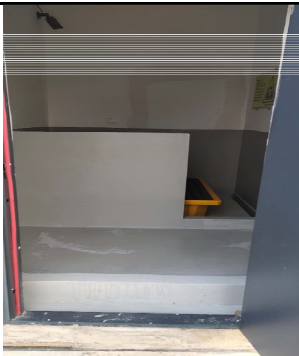
图 6.1-25 危废台门外围堰
