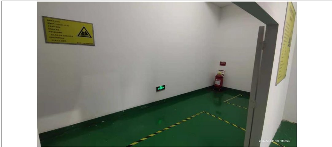
危废暂存间地面铺设环氧地坪
