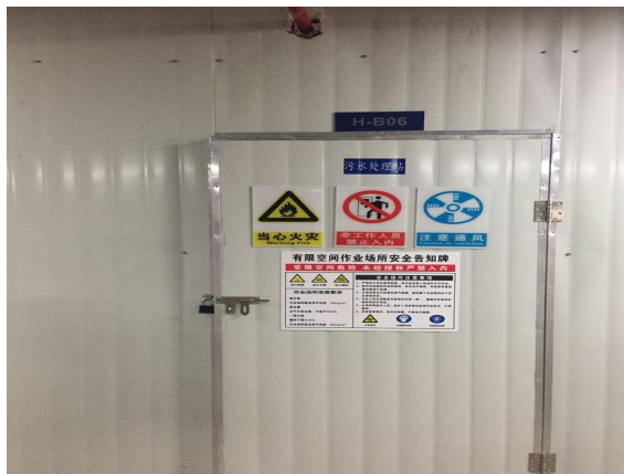
污水处理设施现场照片
