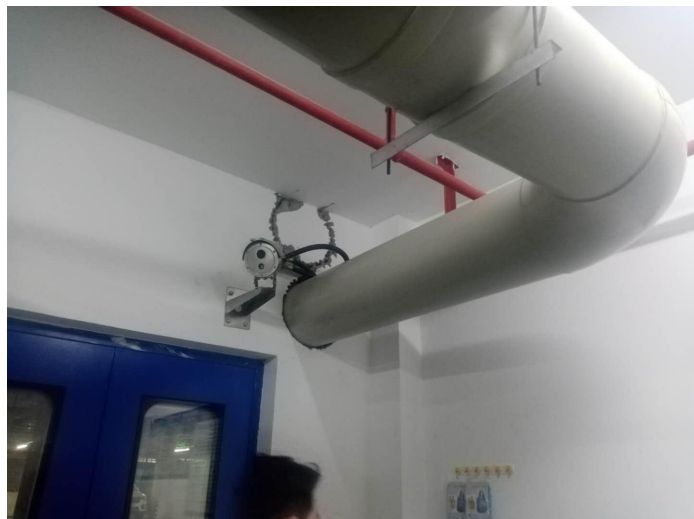
危废库现场照片
