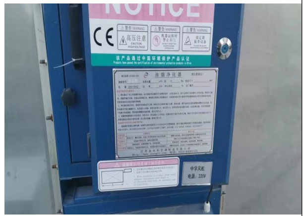
油烟净化处理设施
