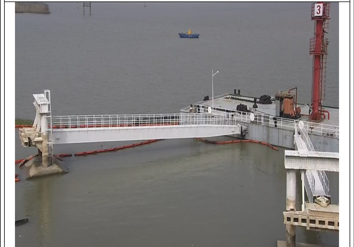
3#码头结构隐患治理后照片
