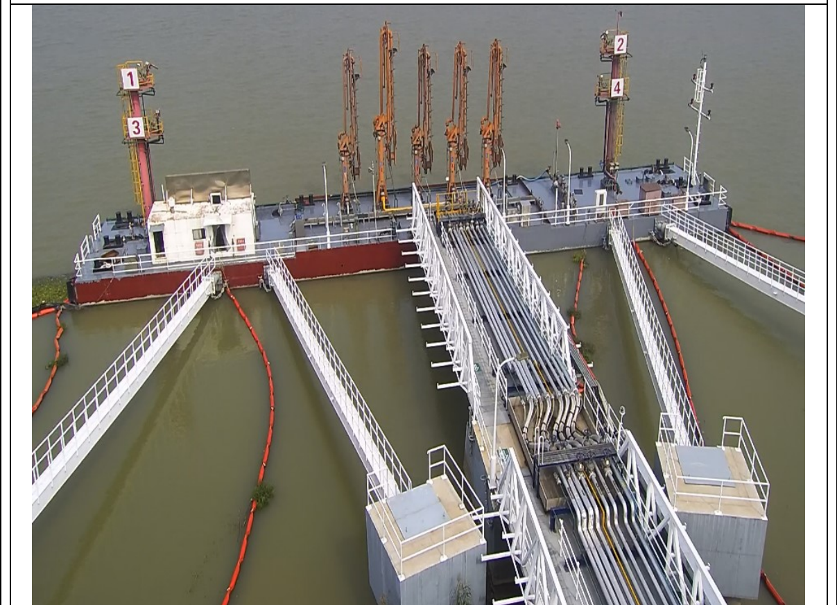
2#码头结构隐患后照片
