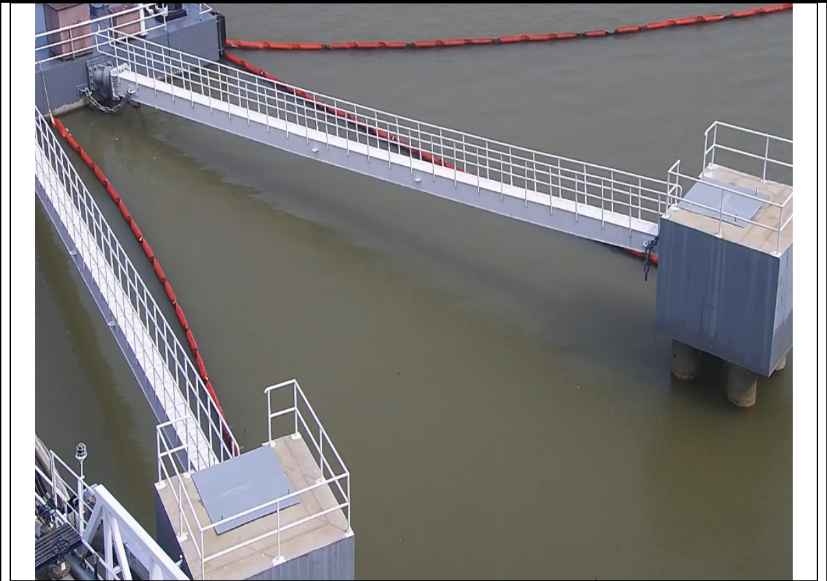
2#码头结构隐患治理后照片
