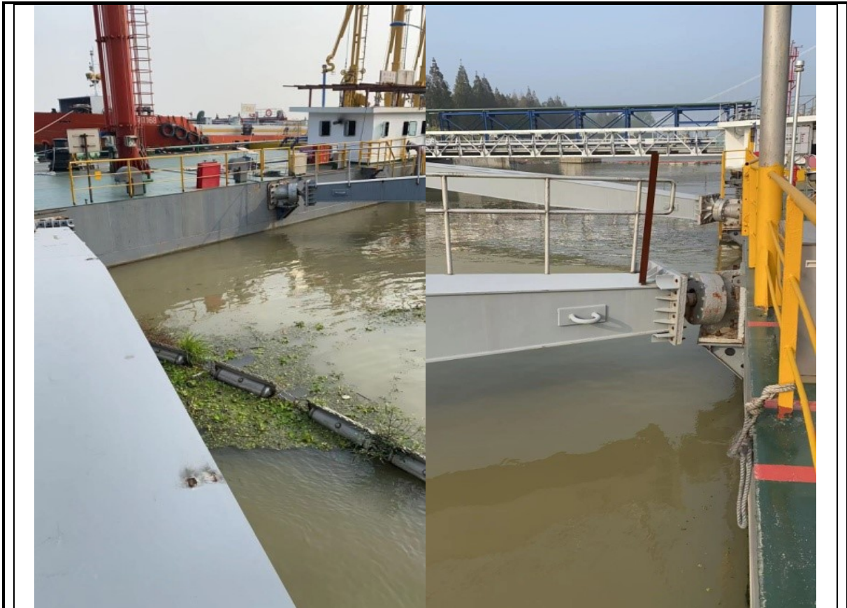
11#码头结构隐患治理后照片
