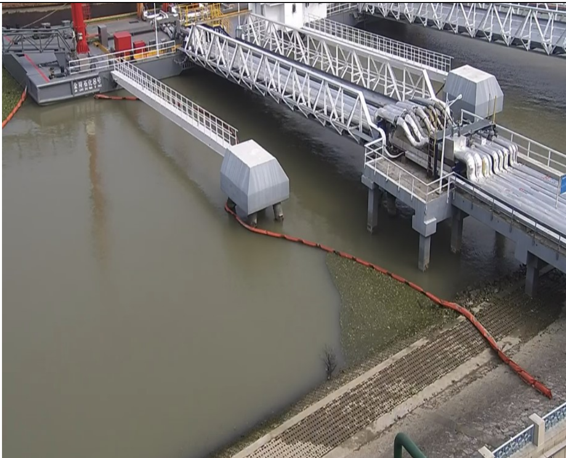
8#码头结构隐患治理后照片
