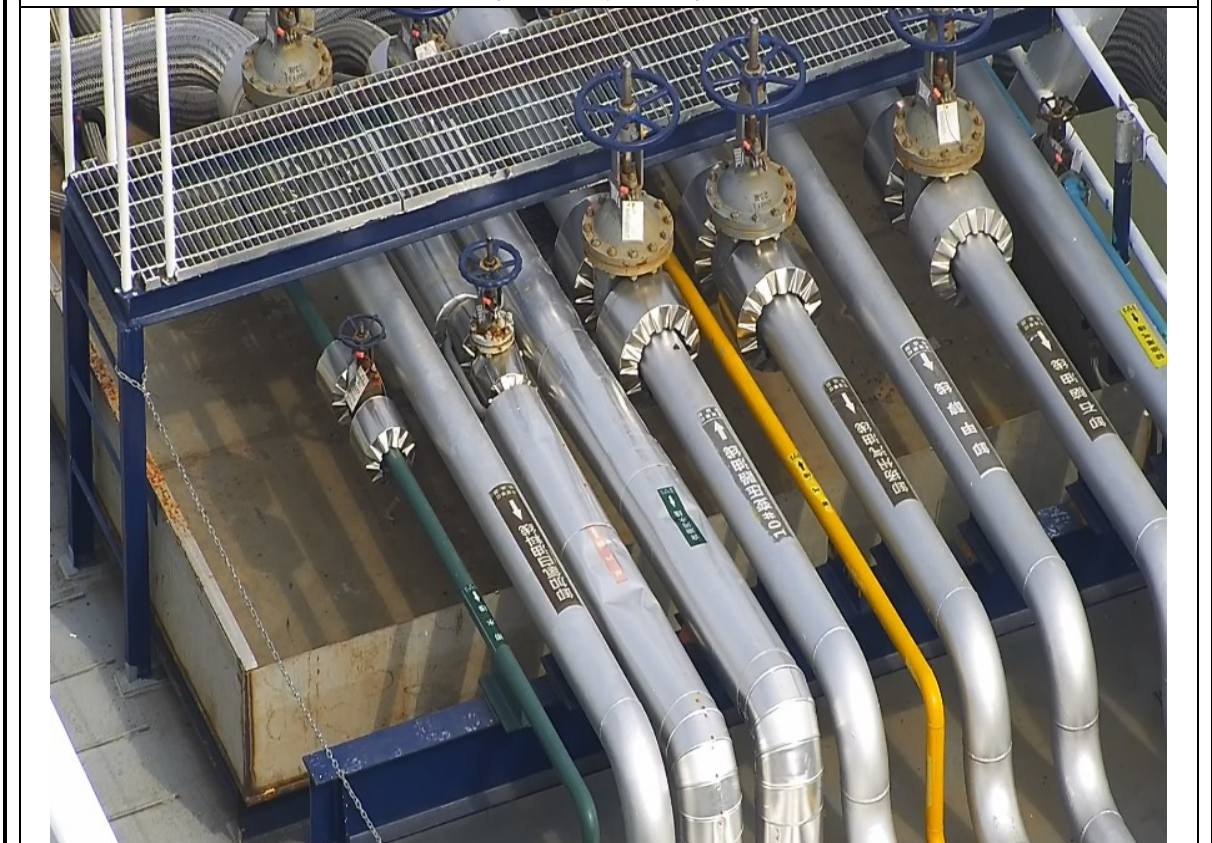
2#码头新增集油舱照片
