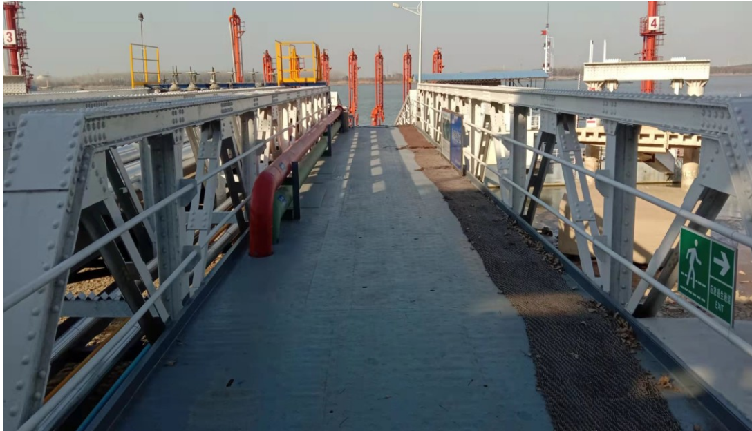
图 3 施工期码头现场照片
