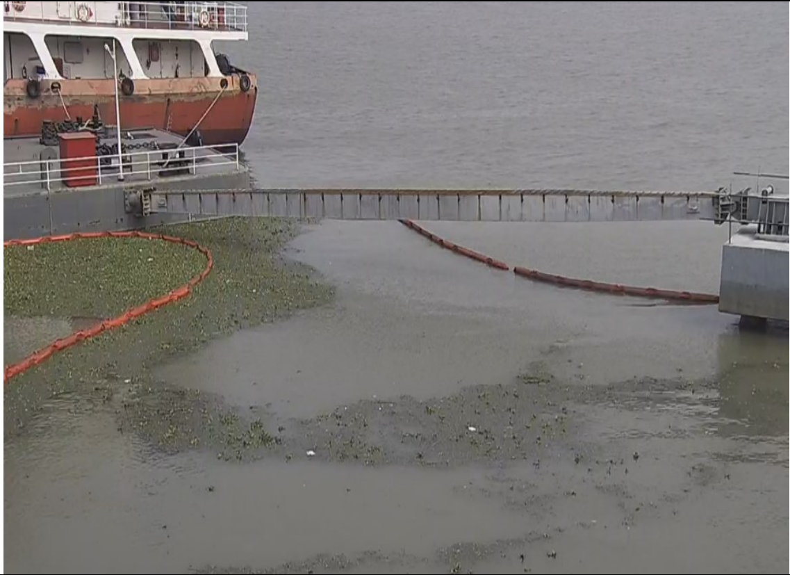
7#码头结构隐患治理后照片
