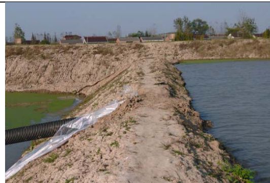
图 4.1-4 施工面临时围埝
