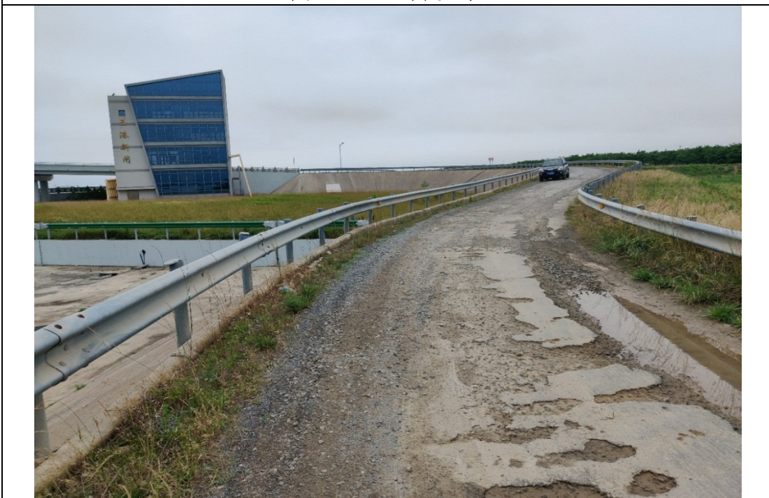
图 2.2-16 南侧防汛道路
