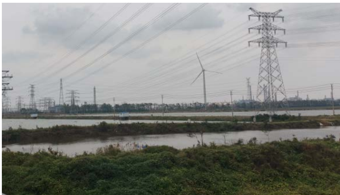
图 2.2-7 弃土区现状照片 1
