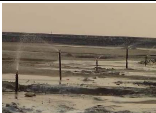
图 4.1-2 施工现场清扫、洒水
