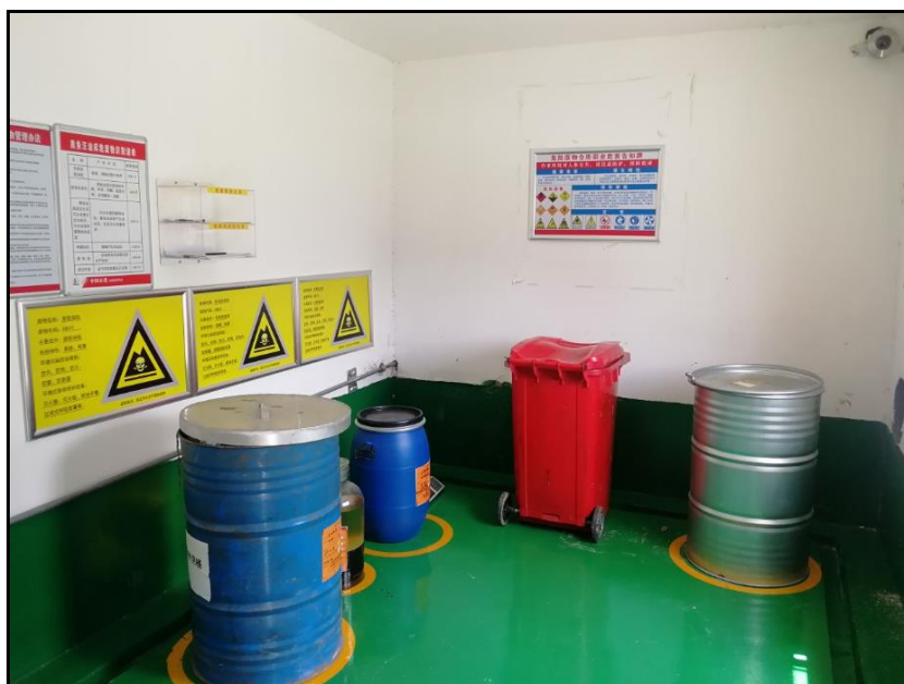
图 3.13-17 宿迁输油站危废暂存现状
