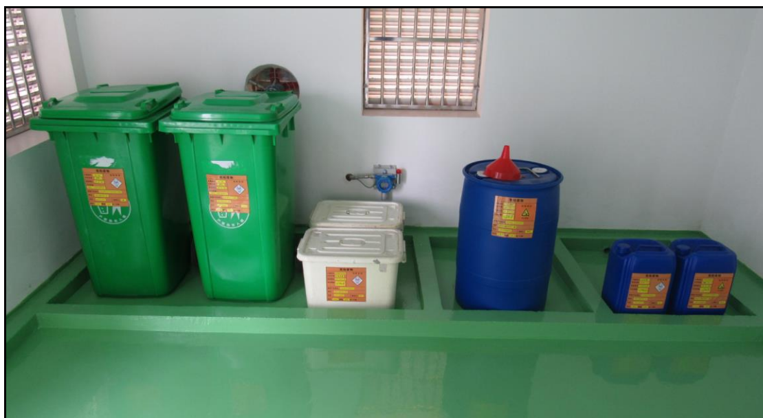
图 3.13-13 扬子输油站危废暂存现状
