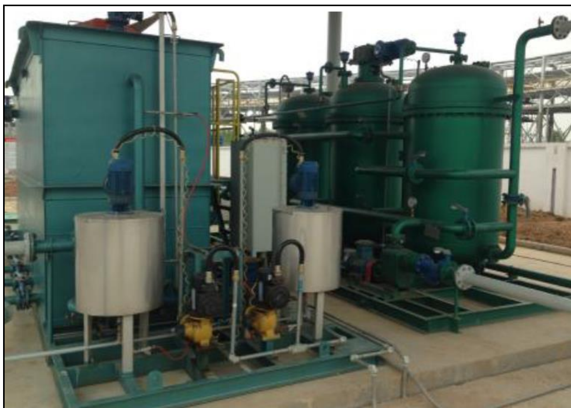
图 3.13-11 宿迁黑鱼汪油库含油废水处理设施（依托）
